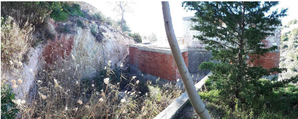
Fotos edificación de la excavación trasera
